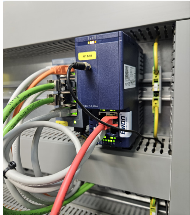
WP2401_4: Je nach Service-Paket, das mit jedem Kunden individuell vereinbart wird, fällt die Wahl entweder auf ein Ewon Cosy+ oder Ewon Flexy-Kommunikationsgateway. Eines der Geräte ist immer mit an Bord und bei älteren Bestandsanlagen wird im Zuge von Retrofit-Maßnahmen die Fernzugriffsmöglichkeit nachgerüstet.
