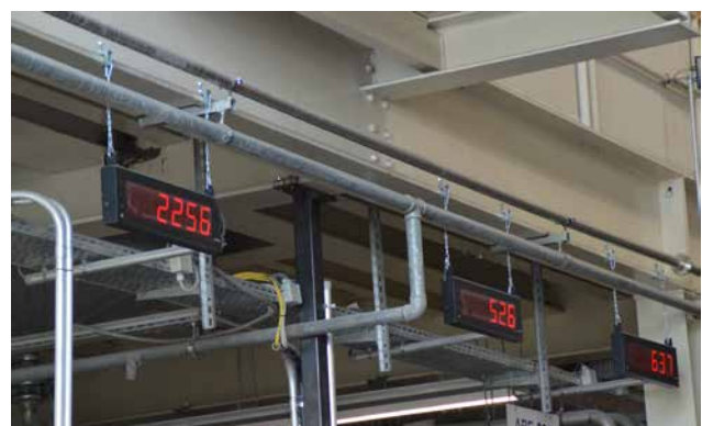
WP1703_6 Die Firma Schulz setzt schon sehr lange auf Wachendorff-Produkte. Hier sind beispielhaft Digitalanzeigen in der Produktion zu sehen.
