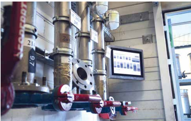
WP1703_4: Ein Panel-PC der ViTAM-Serie von Wachendorff befindet sich in der ungeheizten Schleuse der Tankanlage. Hier werden die Bindemittel mit Tankwagen angeliefert. In dem kleinen Raum werden die Schläuche angeschlossen, um die Flüssigkeiten in die Silos im Inneren zu pumpen. Ein normaler PC hätte hier keine dauerhafte Überlebenschance.
