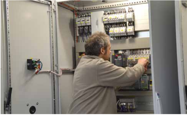
WP1603_8: Momentan wird noch gearbeitet – Peter Harm nimmt die letzten Handgriffe vor.
