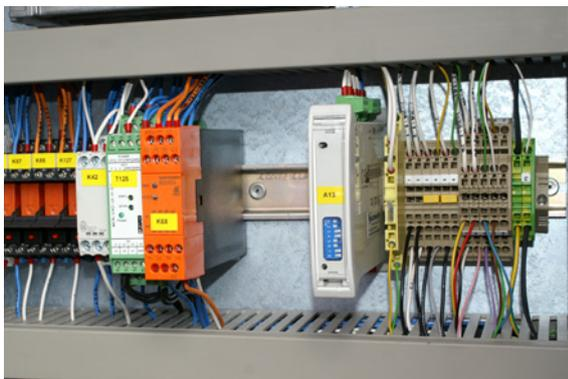
6: Der Repeater sorgt für eine galvanische Trennung und frischt das Signal auf.
