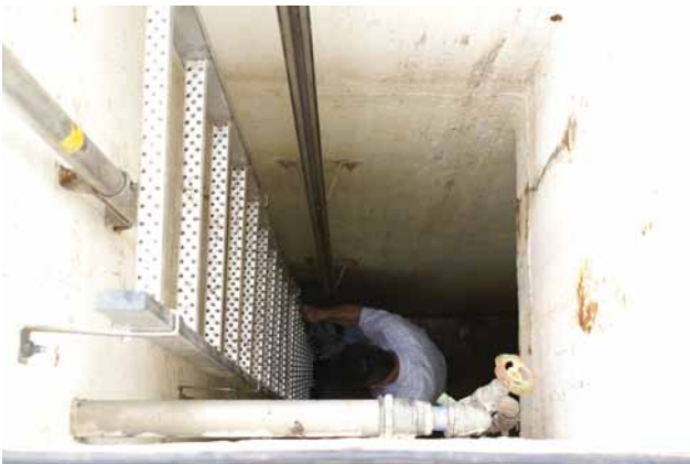
Abbildung 6 In diesen Schächten befinden sich die beiden Pumpen.
