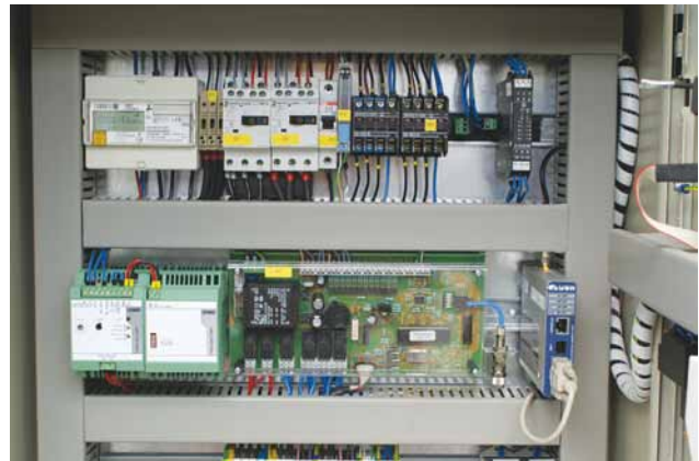
Abbildung 3 eWON wurde in der Verteilung installiert, in der sich schon die Steuerung der beiden Pumpen
