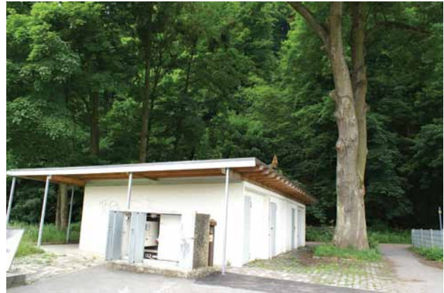
Abbildung 2 Zwischen Waldrand und dem Ufer der Ruhr befindet sich die Pumpenstation.
