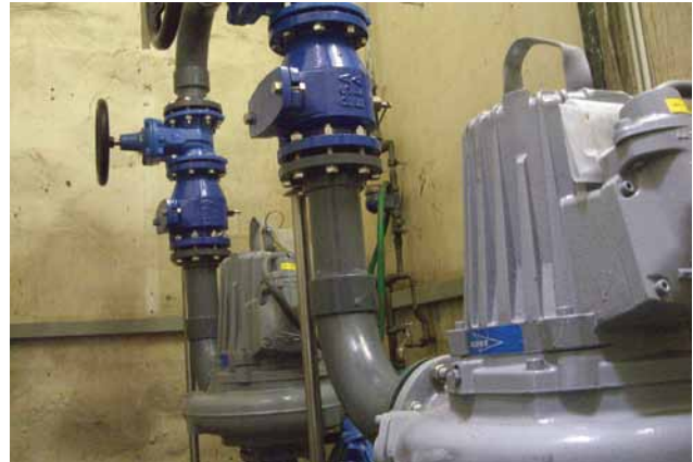
Abbildung 7 Die Pumpen an ihrem Einsatzort – bei Hochwasser droht der Schacht vollzulaufen.
