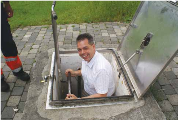
Abbildung 5 Wachendorff-Mitarbeiter Stephan Rump auf dem Weg nach unten in den Pumpenschacht.
