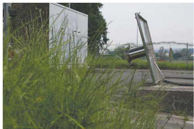
Abbildung 4 Ein massiver Deckel verschließt den Einstieg in den Schacht – daneben hinter dicken Betonplatten der Verteilerkasten.
